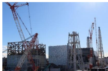
福島第一原子力発電所
